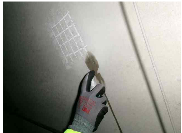
탄산화깊이 측정 현황
